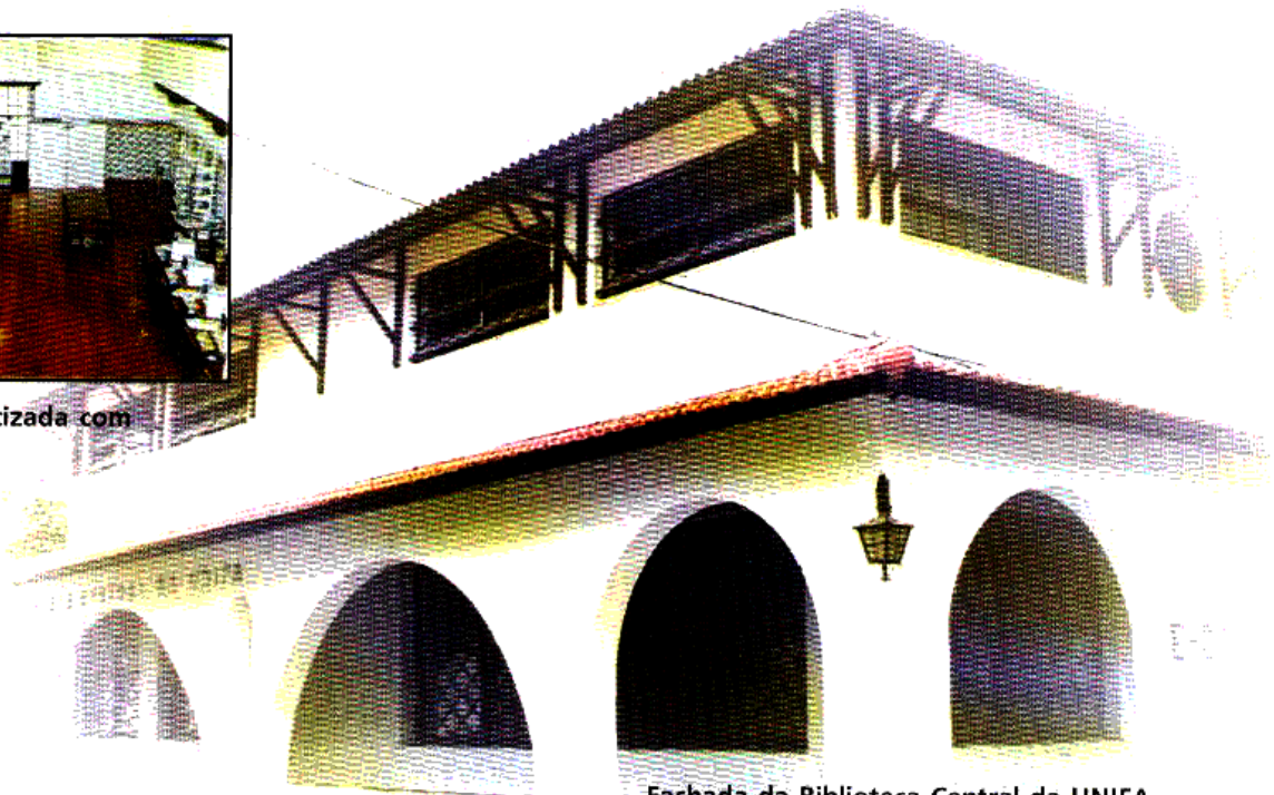
Fachada da Biblioteca Central da UNIFA
