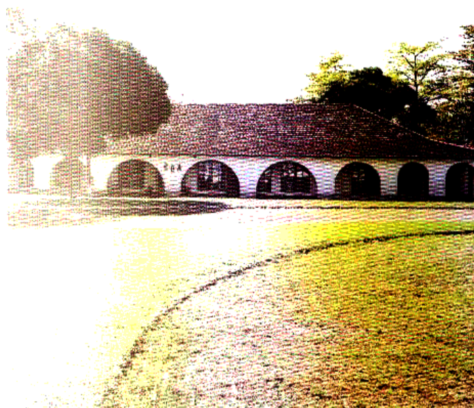
Vista lateral da CDA
