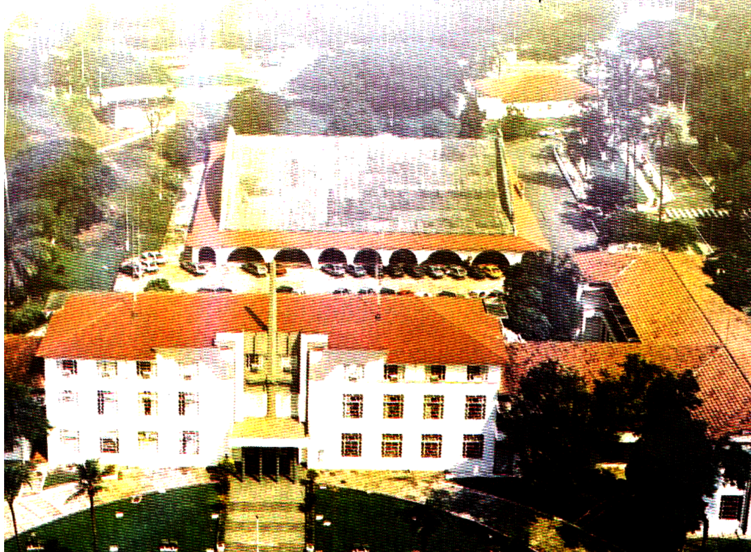
Vista aérea do prédio do comando da UNIFA
