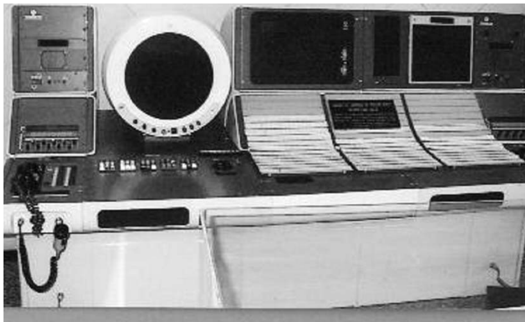
Primeiro console para controle de tráfego aéreo e de defesa aérea em 1976. O equipamento está localizado no salão de honra CINDACTA I.
