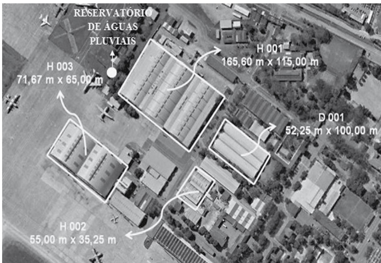
Figura 2: Principais edificações do PAMA-GL. Fonte: Murça (2011).
